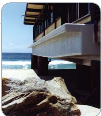
Ресторан в Редонодо Бич — ремонт балок, свай и плит
