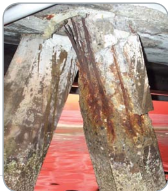
Причал NASSCO, Калифорния — ремонт пораженных коррозией свай
