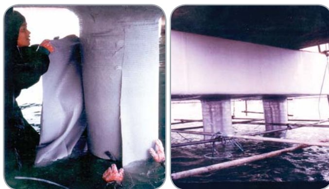
Порт СК — ремонт балок, свай
