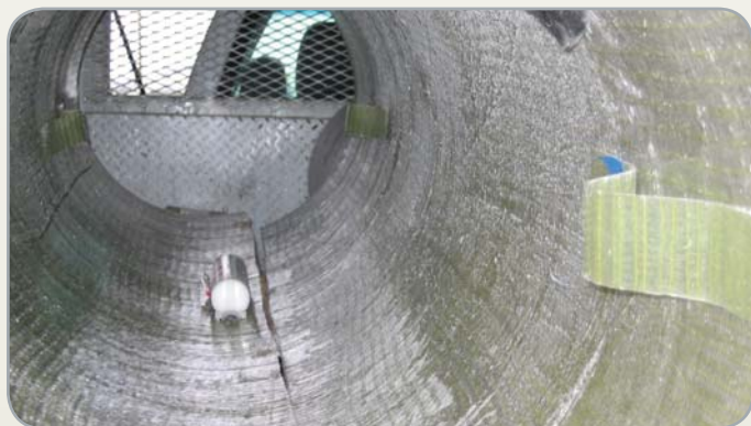
Жилой дом, Малибу — упрочнение свай
