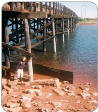
Дарнли Бридж, Канада — усиление деревянных опор моста
