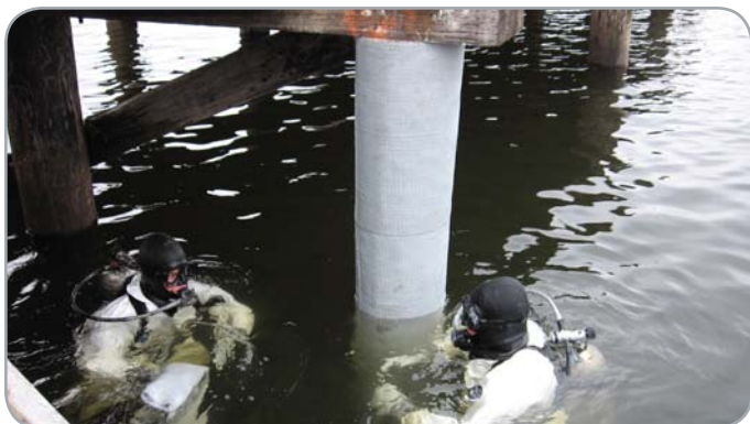
Восточная Канада — ремонт деревянных свай
