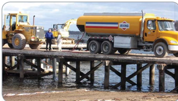
Порт Лонг-Бич, Калифорния — ремонт свай причала
