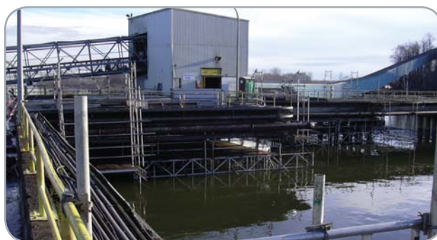
Цементный завод «Лихай Хейделберг» — ремонт балки
