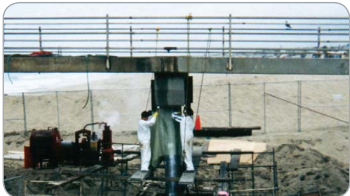
Причал Эрмоса Бич, Калифорния — в процессе усиления опоры моста
