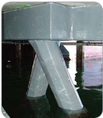
Причал NASSCO, Калифорния — ремонт пораженных коррозией свай
