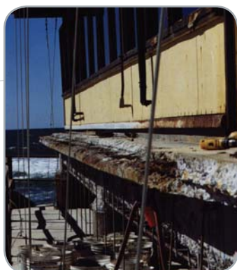
Ресторан в Редонодо Бич — ремонт балок, свай и плит
