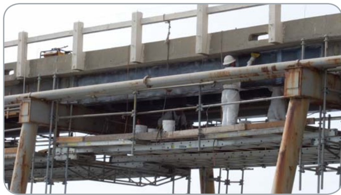
Причал Карпентерья, Калифорния, усиление бетонной балки моста
