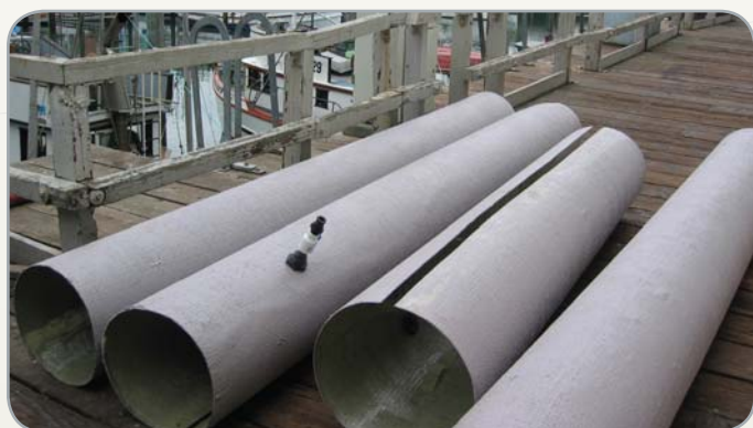
Жилой дом, Малибу — упрочнение свай
