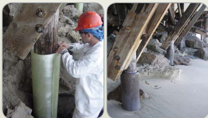
Жилой дом, Малибу — упрочнение свай
