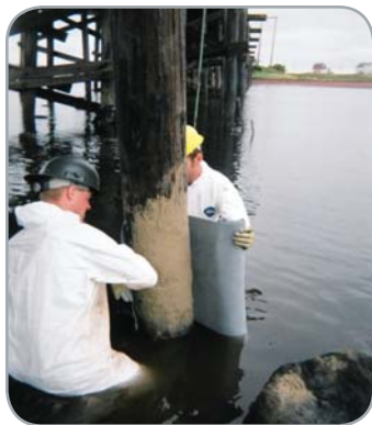
Дарнли Бридж, Канада — усиление деревянных опор моста
